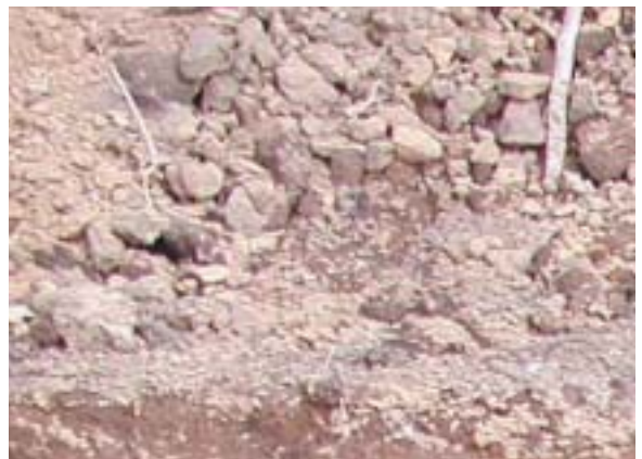
中央窪地深堀部分土層堆積状況
